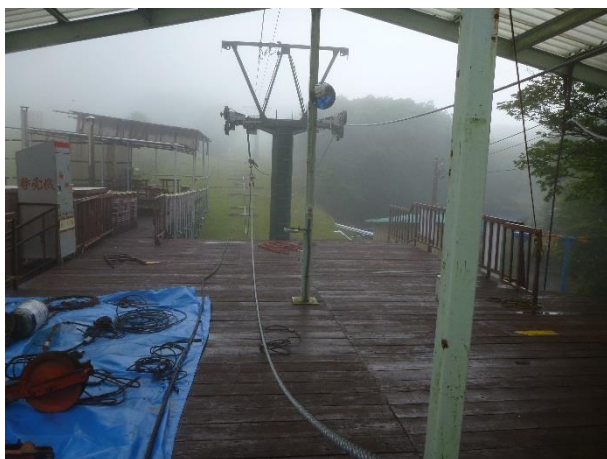
(山上リフト支えい索更新)
