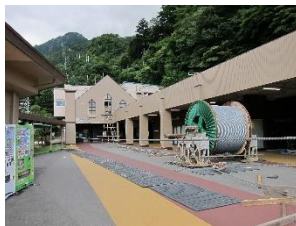
◇えい索交換工事の様子
