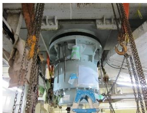
◇山上リフト原動滑車ベアリング交換の様子
