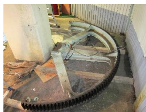
◇山上リフト原動滑車ベアリング交換の様子
