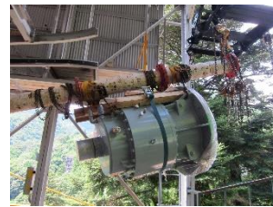
◇減速機運搬の様子
