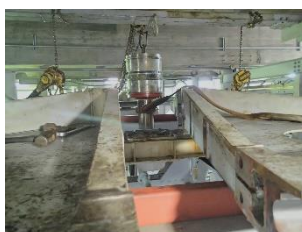
◇滑車軸組更新の様子
